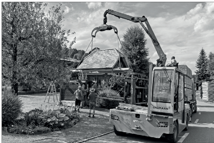
10. September 2024, 11:37 Uhr: Das Chäppeli erhält das neue Dach.
