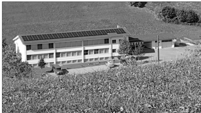
Neue PV-Anlage auf dem Dach des Schulhauses Sagenmatt
