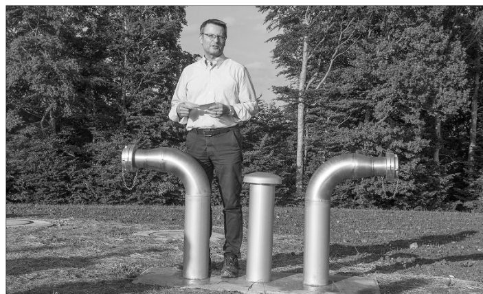
Pius Hodel bei seiner Rede. Vor ihm die zwei Ansaugrohre für die Motorspritzen der Feuerwehr und in der Mitte das Belüftungsrohr.
