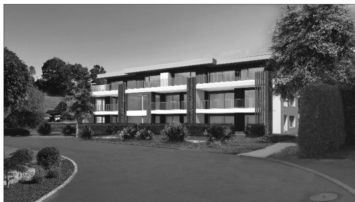
Neubauprojekt Mehrfamilienhaus Unter-Schniderbure
