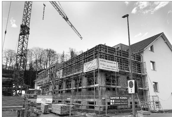
Stand Erweiterungsbau 17. Dezember 2020
