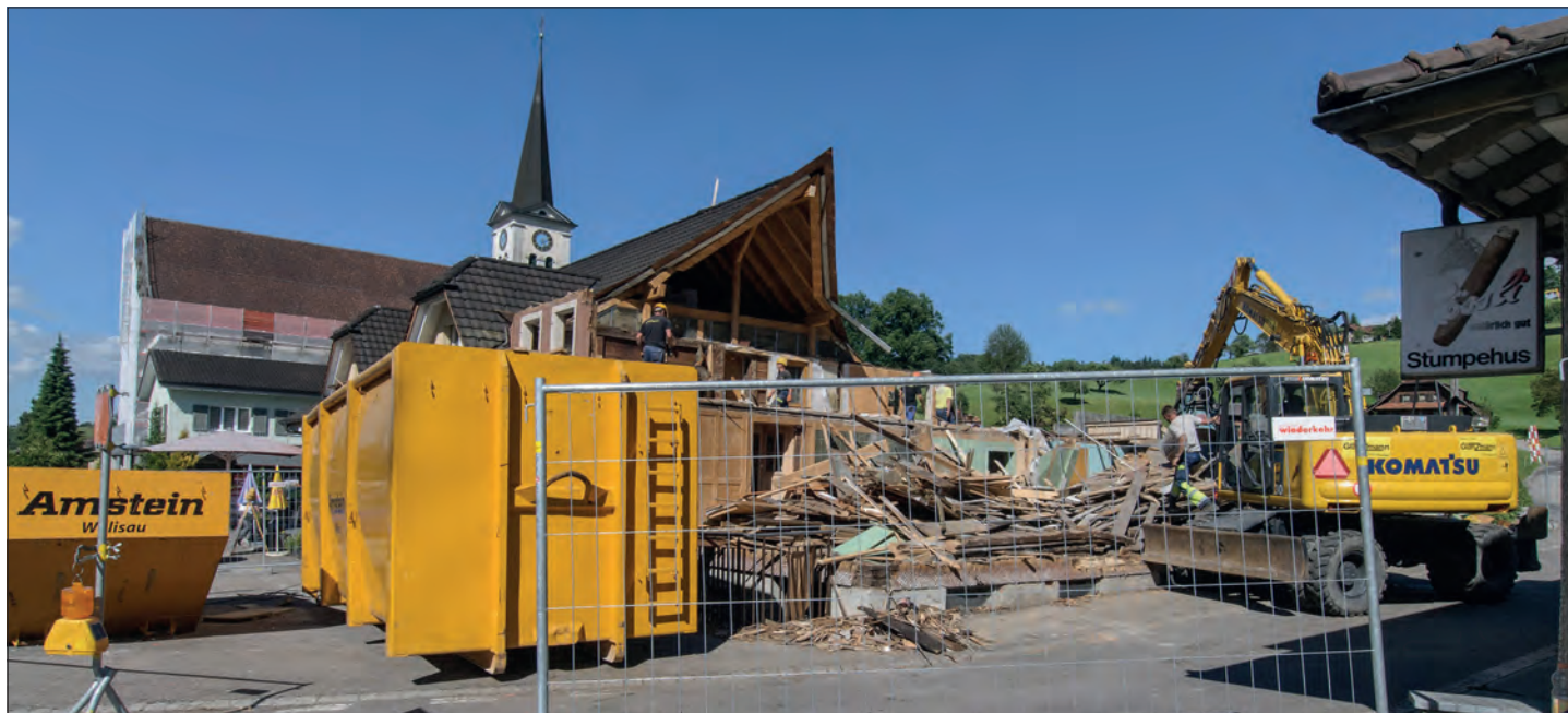
Die Firma Glanzmann Tiefbau GmbH beim Abbruch des alten Teils des früheren Ludihauses.
