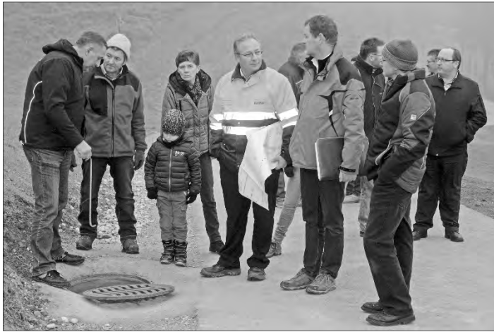
Bei der Bauabnahme werden sämtliche Schächte kontrolliert. In der Bildmitte Reto Graber, Iawa Kanton Luzern, und Guido Müller, Plan Quadrat AG Willisau. Bild: Peter Helfenstein
