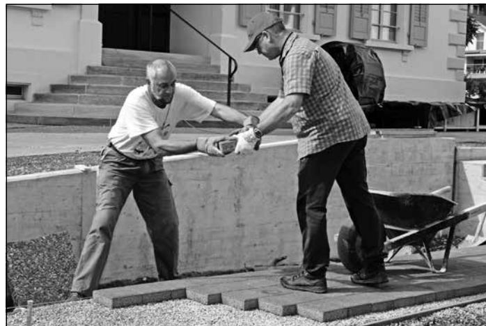
Das ist Teamarbeit: Hans Marti (links) und Andreas Pauli arbeiten beim Plattenlegen Hand in Hand. Bild: Peter Helfenstein
