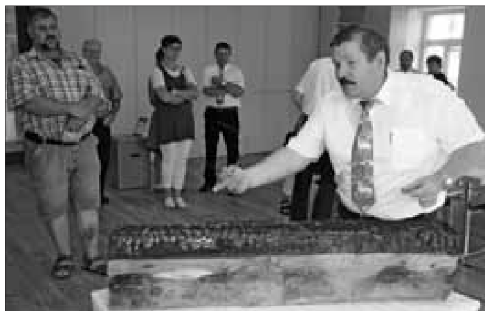
Baukommissionspräsident Walter Grüter zeigt auf dem Rundgang einen angebrannten Holzbalken. Bild Peter Helfenstein
